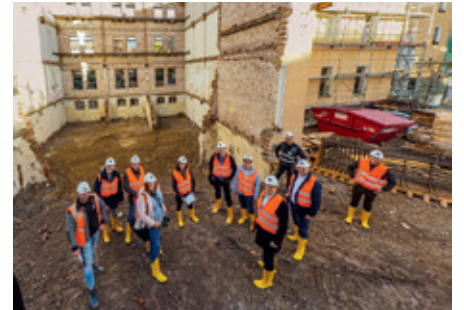
Die Besucherdelegation vor den freigelegten historischen Fassaden, die fachgerecht restauriert und erhalten bleiben werden.
