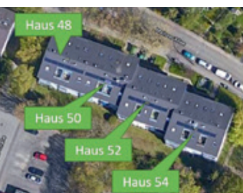
In 40 Wohnungen werden Wasserleitungen, Bäder und WCs erneuert.
