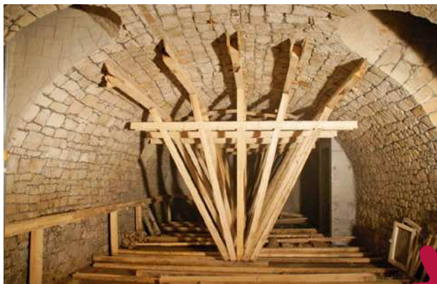
Eberhardstraße 1: Nach Sanierung und Umbau neues Domizil für Städtisches Museum, Kunstverein und Touristinformation.
