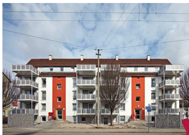
Architekt: Reiner Balko
