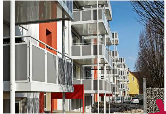
Neben einem Wärmedämmverbundsystem erhielten die Wohnungen in der Friedrich-Ebert-Straße angebaute Balkone.
