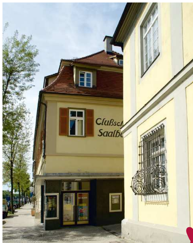
Raum für Kultur: Bereits saniert und energetisch modernisiert wird die Scala-Immobilie 2012 umgebaut und erweitert.
