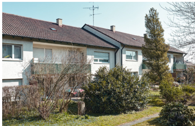
Die Bühlerstraße 40 und 42 vor der energetischen Modernisierung im Jahr 2012.
