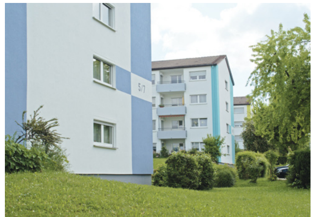
In der Besigheimer Straße wurden mehrere Wohnblocks mit einem neuen Farbkonzept gestaltet.
