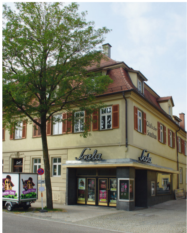
Im Herbst 2014 eröffnete nach dem umfassenden Um- und Erweiterungsbau das „alte“ Scala in neuem Glanz.
