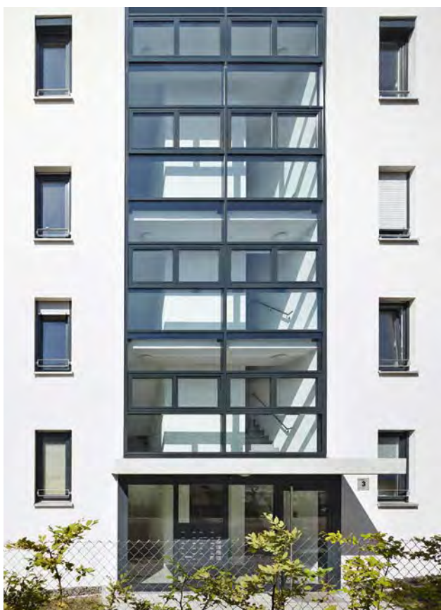
Am Sonnenberg 3: Das „Fair Wohnen“-Modell der Wohnungsbau Ludwigsburg am Sonnenberg hat sich bestens etabliert. Architektur: Project GmbH
