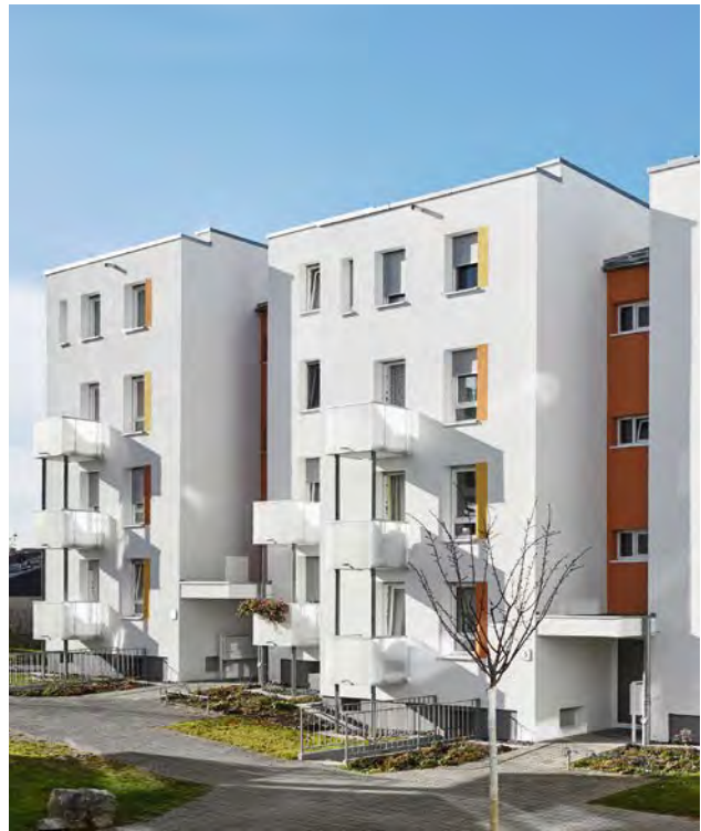
Ingersheimer Straße 3 und 5: Ein Beispiel des Fitnessprogramms für Bestandsgebäude durch energetische Gebäudemodernisierung. Architektur: Kelzenberg + Jahnke
