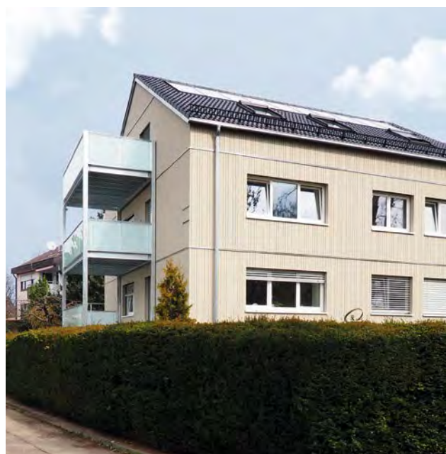
Karl-Dieter-Straße 24: Im Rahmen des EU-Forschungsprojekts iNSPiRe wurde mit vorgefertigten Fassadenelementen saniert. Architektur: Kelzenberg + Jahnke
