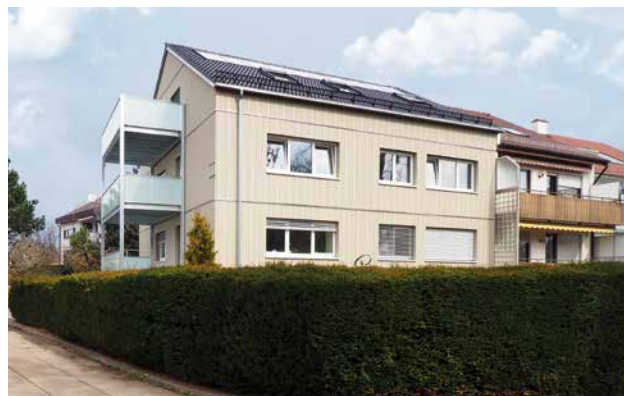
EU-Projekt iNSPiRe: energieeffiziente Modernisierung mit Fertigbauteilen in der Karl-Dieter-Straße. Architektur: Kelzenberg + Jahnke
