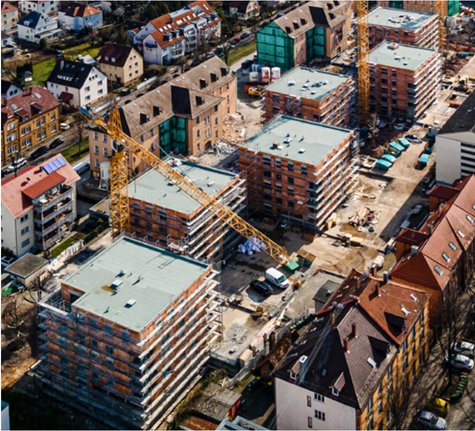
Planmäßiger Baufortschritt: Die Rohbauten von sechs Punkthäusern im JägerhofQuartier wurden fertiggestellt.
