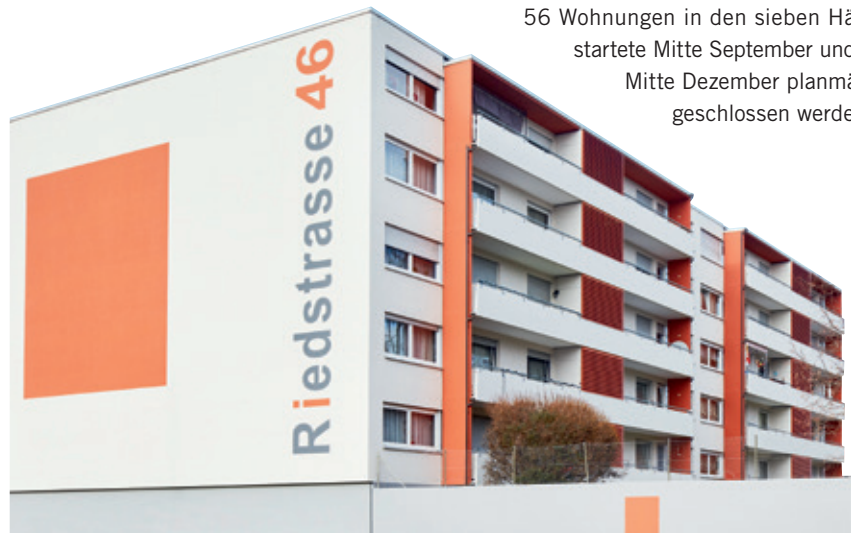
Das Tüpfelchen auf dem i: Der neue Fassadenanstrich in der Ried-/Baldeckstraße setzt frische Akzente.
